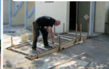
réalisation d'une rampe pour personne à mobilité réduite
