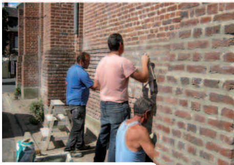
rejointoiement à l'église
