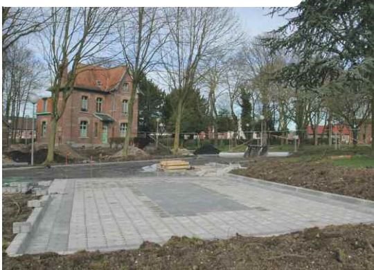
place de parking en pavés drainants
