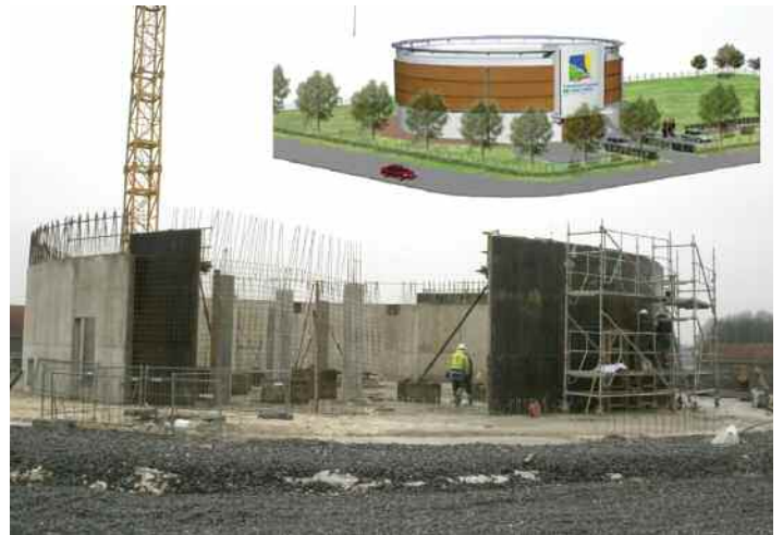
Le réservoir en construction et son aspect définitif à la fin des travaux.
