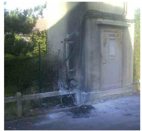
*Une armoire d'éclairage public et les câbles d'un transformateur brûlés.*
