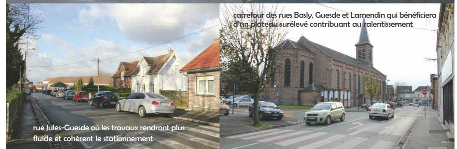
des chicanes ralentiront la vitesse dans la rue Jules-Guesde, une route en ligne droite favorisant la vitesse
