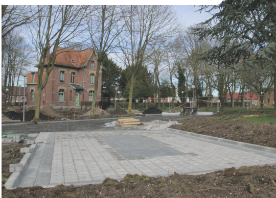
place de parking en pavés drainants
